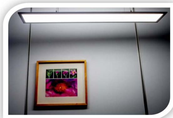
LED afhang-armaturen met tunable white en 60% down- en 40% up light
